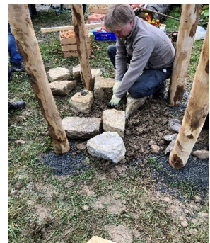
Pfosten mittels Wasserwaage begradigen, Fundamentlöcher mit Splitt füllen. Ca 2,5kg Splitt pro Loch
