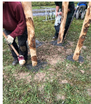
Pfosten mittels Wasserwaage begradigen, Fundamentlöcher mit Splitt füllen. Ca 2,5kg Splitt pro Loch
