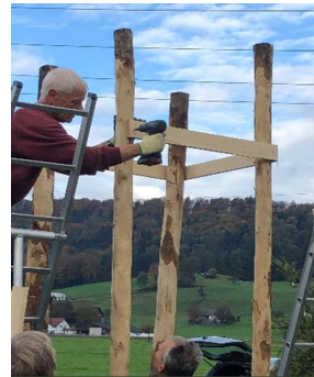
Die Pfosten (Kastanienholz Länge 4m) in die Löcher stellen
