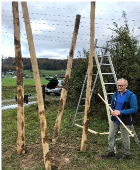
Die Pfosten (Kastanienholz Länge 4m) in die Löcher stellen
