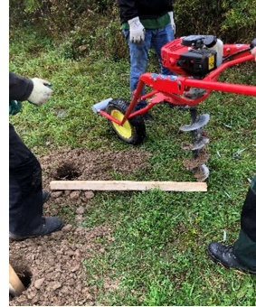
Fundament ca 50-80cm tief mit Erdbohrer bohren für die vier Eckpfosten
